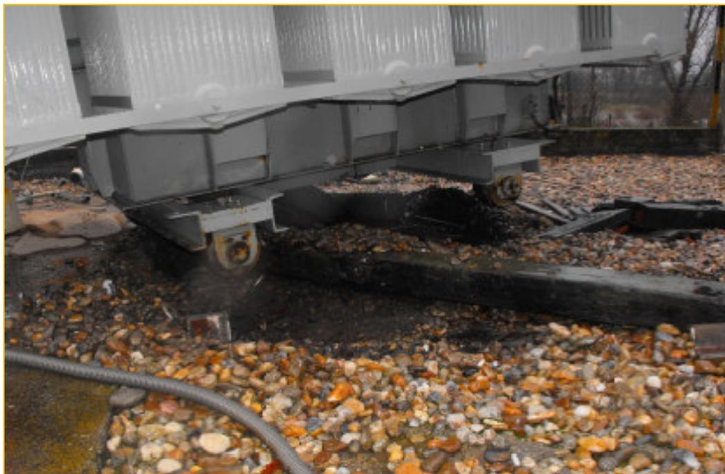
Fotografía: Vertido de aceite térmico de transformador
